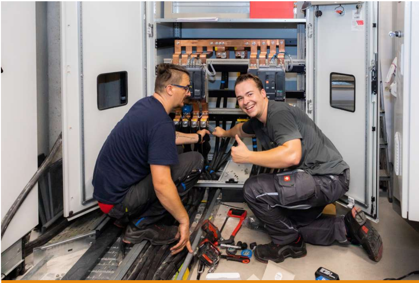
Am LGI-Standort Ketsch ist ein Tool zur Energieeinsparung des Anbieters E-Saver im Einsatz. Damit sollen Kosten reduziert und CO 2 eingespart werden. (Foto: LGI)
